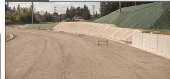
土木一式工事 市道辻前遠堀線道路改良工事
