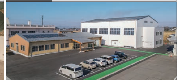
建築工事 志波姫公民館建設建築工事
