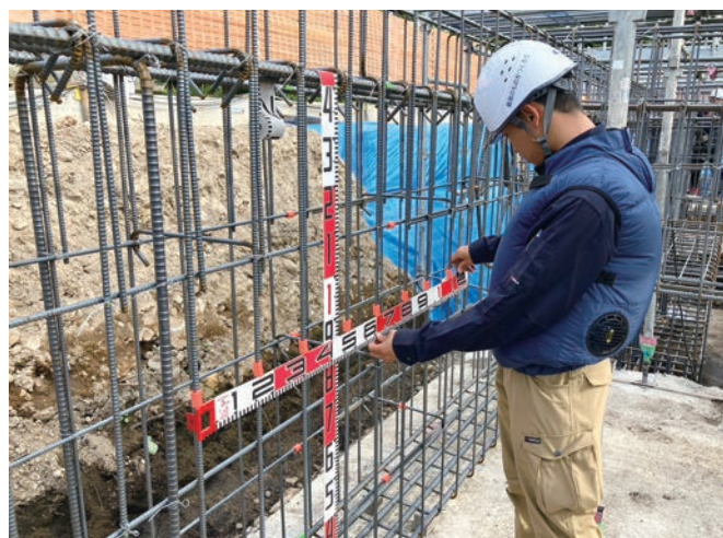
現場で配筋の状態を確認する武田さん
