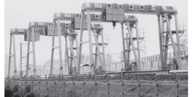
■ 橋型クレーン
