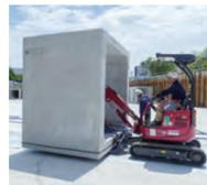
同工法は、空気圧縮機からエアーホースで正方形の台車に圧縮空気を送り込み、空気圧を利用して重量物を浮上させ搬送するシステム。現場に搬入されたボックスをクレーンで約3.5m下の地盤にあるエアーキャスター上に降ろし、所定の位置に移動させる。移動中の摩擦抵抗がほとんどないことから、人力による移動も可能で、今回の現場ではエアーキャスター4枚1セットを使用した。さらに、移動に当たり滑りをよくするため、ガルバニウム鋼板を敷いたほか、ボックスのコントロール用に使用しているミニバックホウの排土板とバケットに製品に傷を付けないようゴムを装着させるなど、きめ細かな対応を行った。
