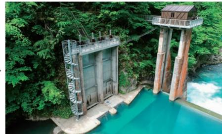
▲改修後(固定堰の補修、取水口の耐震補強、ゲートの更新など)
