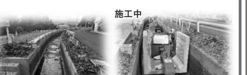
本工事は、国営八郎湯土地改良事業計画に基づき、既設の開水路[コルゲートフリューム(B4,100×H1,400、延長=594.1m)]を撤去し、強化プラスチック複合管布設工(FRPM管φ1,500mm、延長=598.62m)により、F2幹線用水路を改修します。
